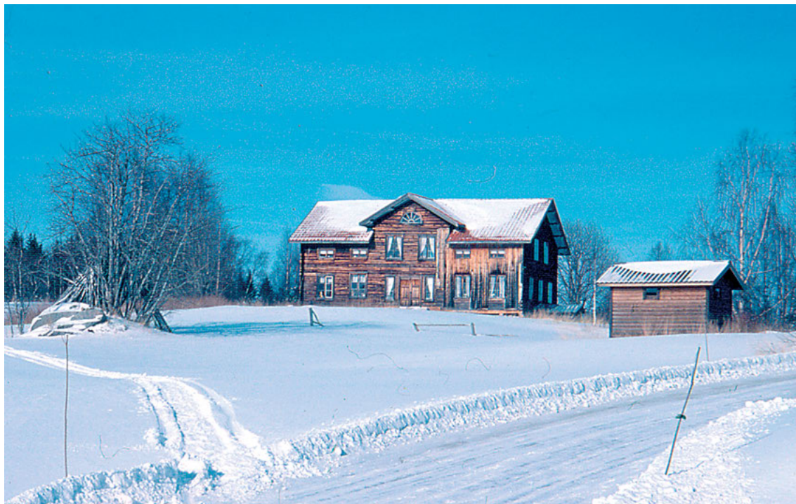
FIGUR 10. Oppigårdens huvudbyggnad, ett av byns stambemman, centralt beläget på en höjd i byn. Fastigheten har stort symbolvärde och den varken säljs eller hyrs ut till utomstående. Den gamla omålade byggnaden har stått tom i generationer men tak och fönster underhålls i avvaktan på att någon med anknytning till byn är beredd att rusta inför ett eventuellt fastboende. Foto Gert Magnusson.
