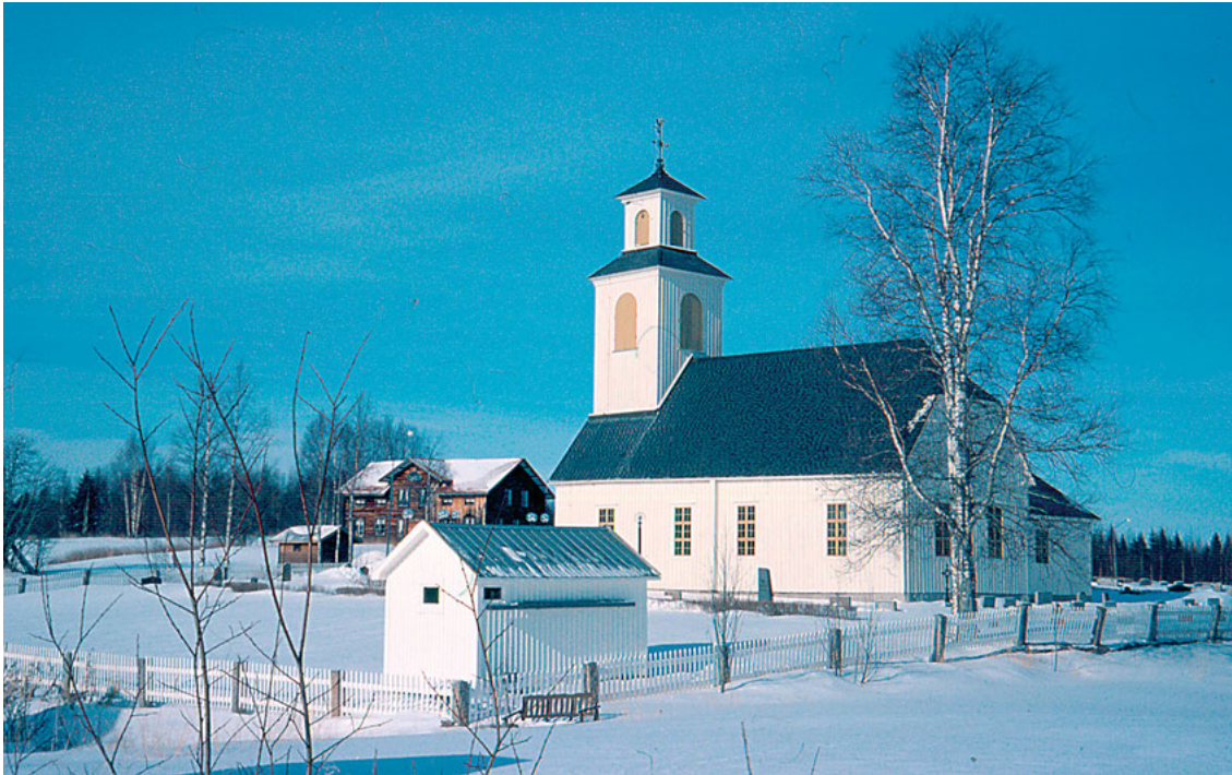
FIGUR 9. Ängersjö kyrka med Oppigården i bakgrunden. Kyrkan byggdes i slutet av 1700-talet och har genomgått flera stora renoveringar, sista gången år 1931. Foto Gert Magnusson.
